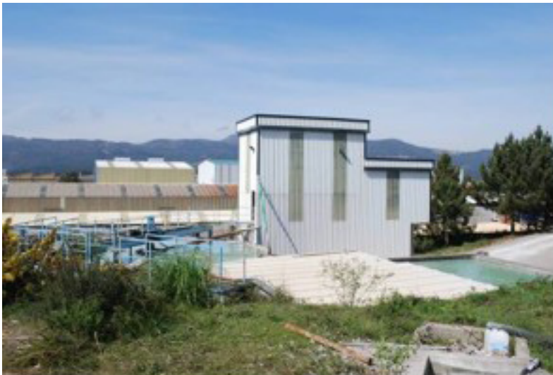
Decantadora e zona de bombeo
