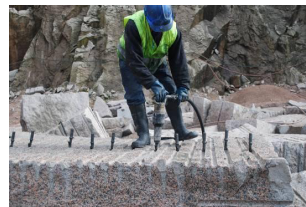
Accionamento pneumático das cuñas para a separación dos desquites
