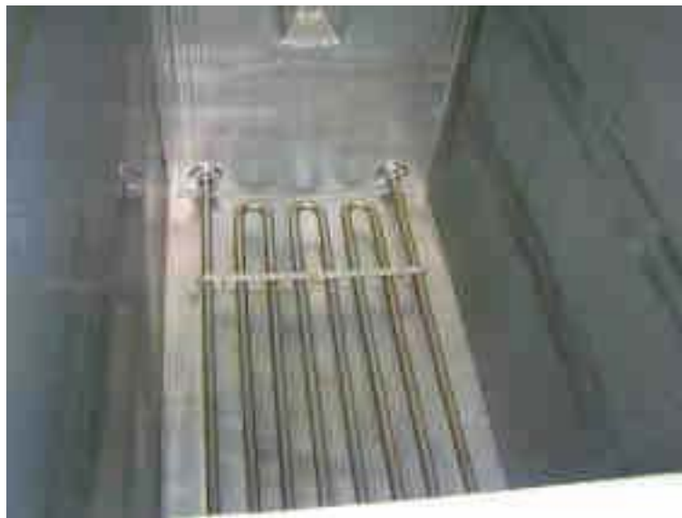
Serpentín de intercambio de calor dunha balsa.
