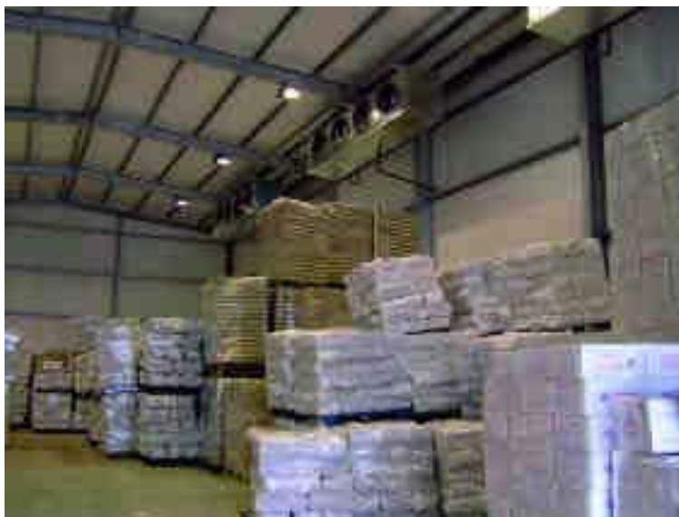
Interior de cámara frigorífica
